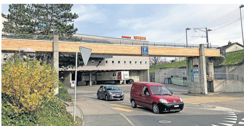
Die neue Brücke bei der Migros stammt von der Tschopp Holzbau AG. Fotos pd/aw
